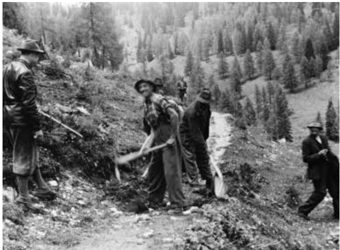
Triebwegbau zur oberen Hirtenhütte der St. Stefaner Alm, 17. Juni 1957.
