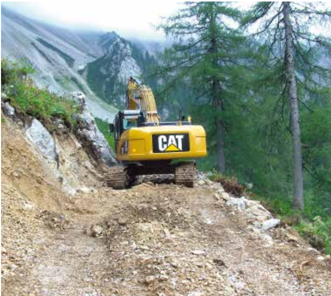
Errichtung des neuen Weges auf die Matschacher Alm, 2008.
