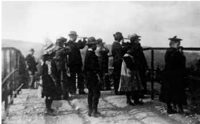
Ausflügler aus Klagenfurt verfolgen den Baufortschritt der Karawankenbahn, Rosental 1906.
