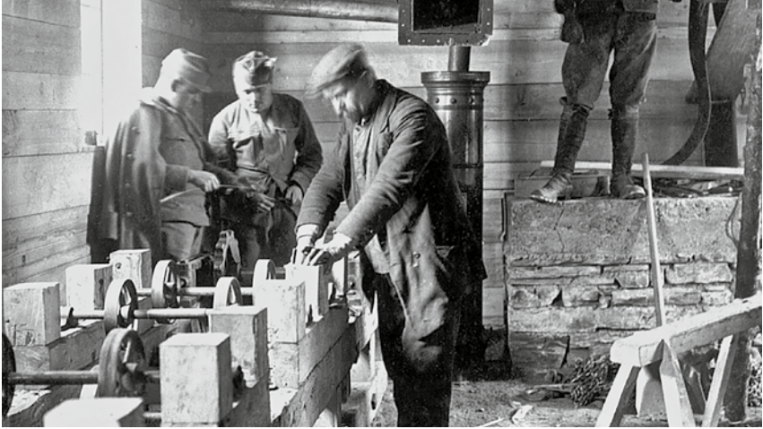
Aufbereitungsanlage, Innenansicht, k. u. k. Kiesbergbau, Großfragant, um 1916. Foto: Bildarchiv Austria, ÖNB, Wien
