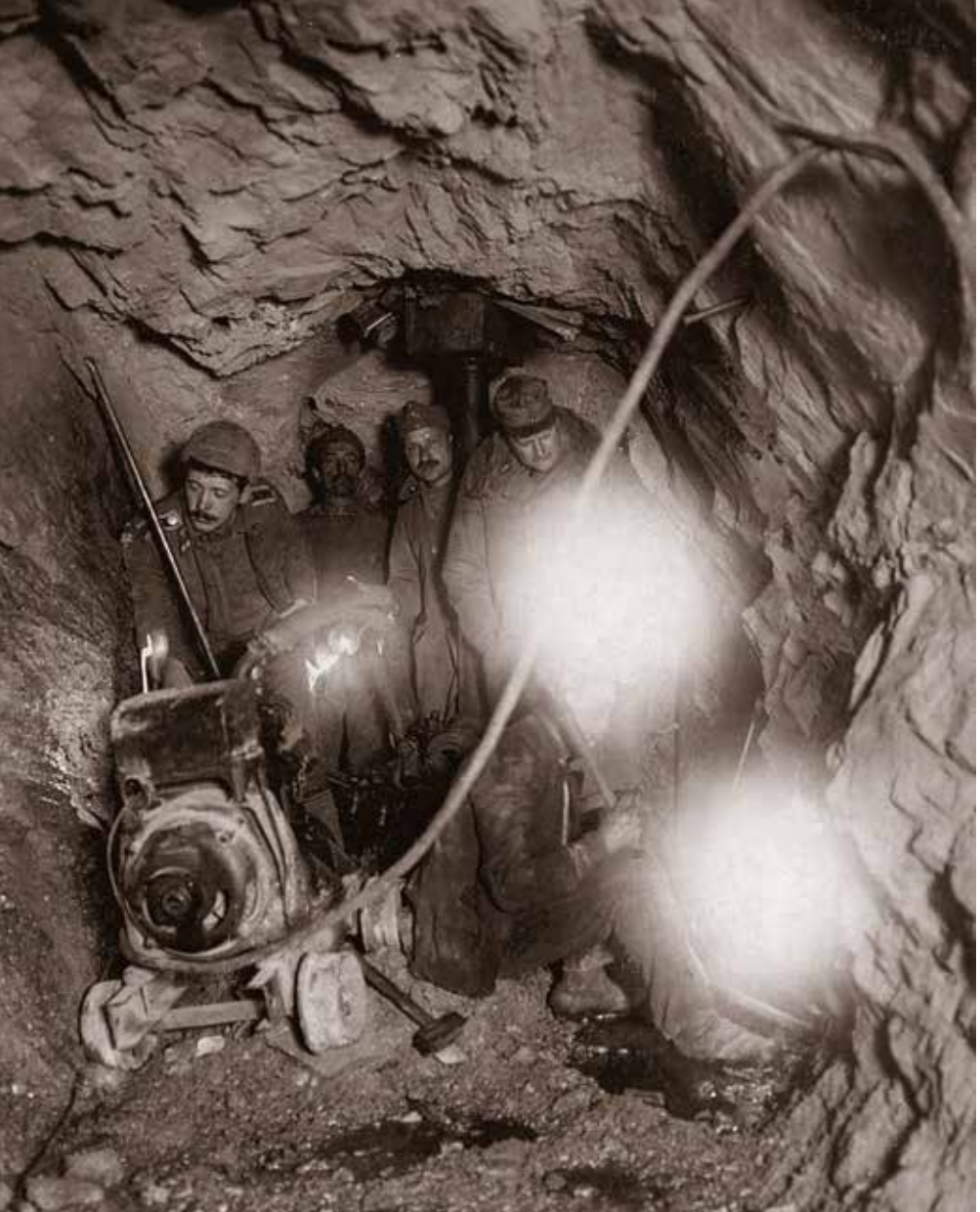
Stollenvortrieb mittels Standbohrmaschine, k. u. k. Kiesbergbau, Großfragant, um 1916. Foto: Bildarchiv Austria, ÖNB, Wien
