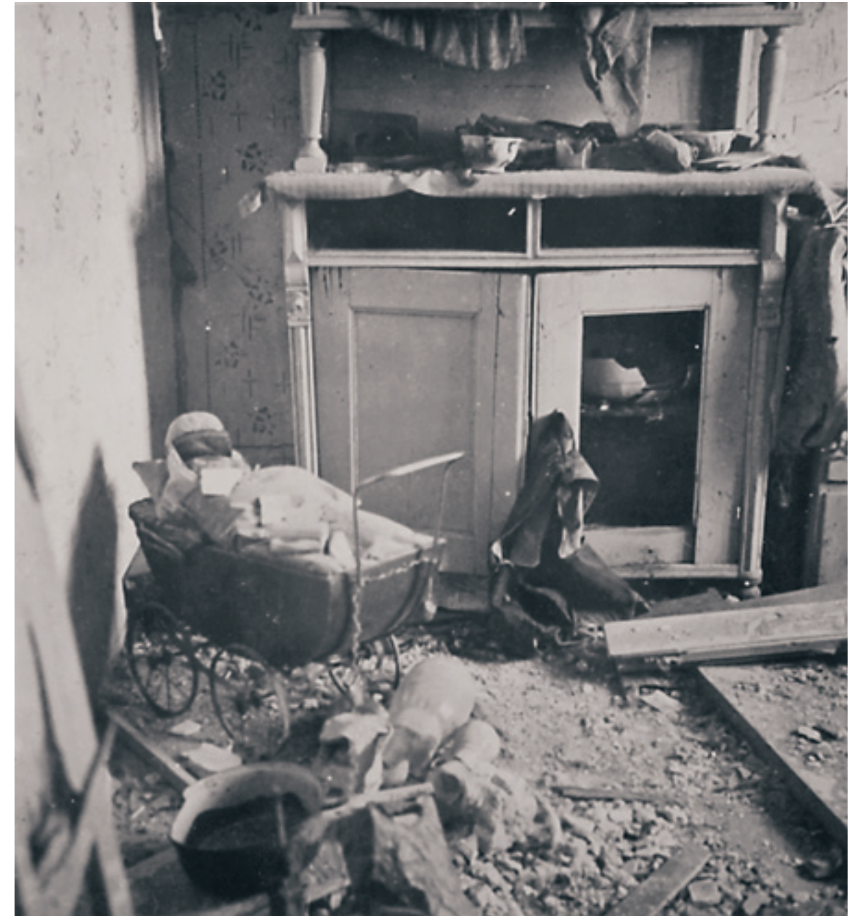
2.36 Zerstörte Gemeindebauwohnung, Wien, Februar 1934. Wien Museum > Die Niederlage der Arbeiterbewegung besiegelte das Ende der jungen österrei- chischen Demokratie.
